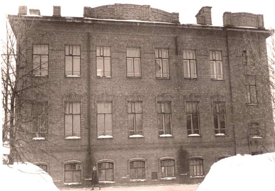
Первое здание Пермской с.-х. опытной станции, 1915 г. / The first building of Perm Agricultural Experimental Station, 1915
