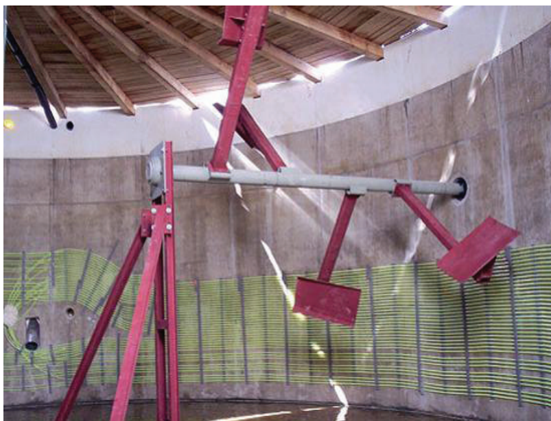
Рис. 2. Общий вид размещения лопастной мешалки в ферментационной камере с установленным обогревателем
